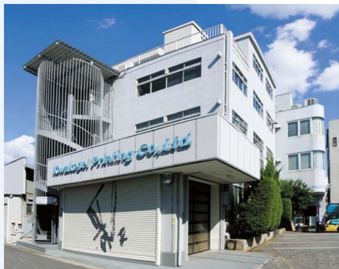
巧和工芸印刷株式会社・工場
